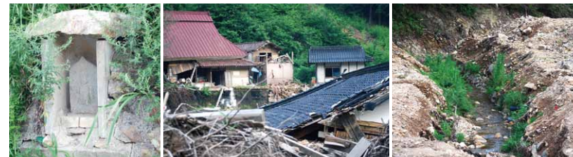
土石流で崩れた家々。ここにあってであろう生活の欠片がそのまま残されている。
